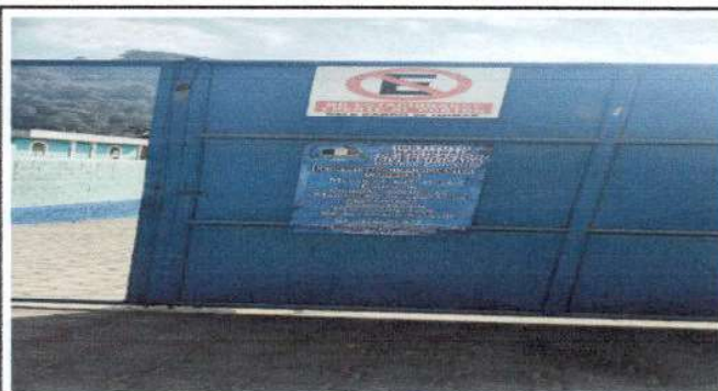
Foto 4: Se inicia con las medidas del techo del portón.
