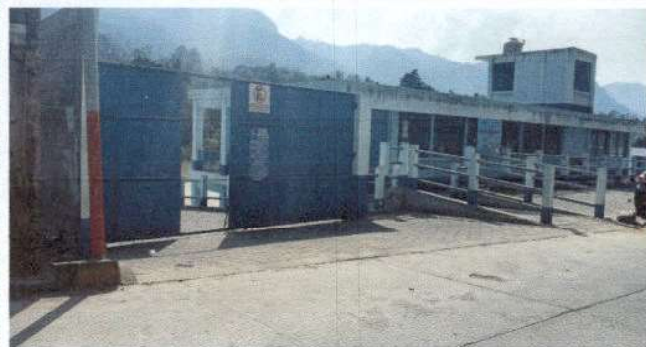
Foto1: Inicio de pintura de muros e interiores
