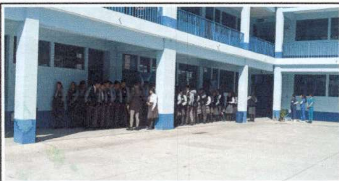
Foto 3: Inicio de pintura de barandales
